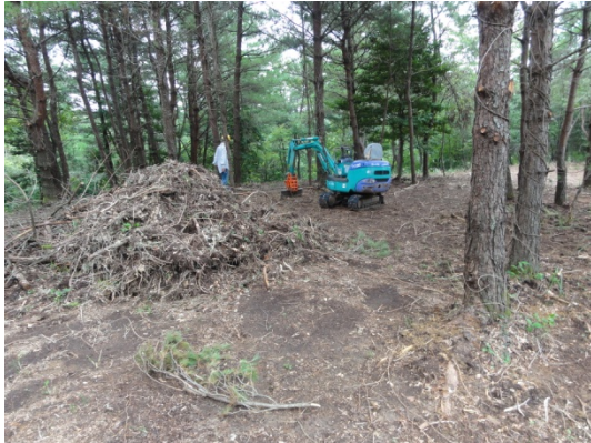
地掻きを行った林内
